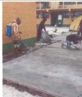
Foto 4: 6 PISO (6.1 Reparación de piso de torta de concreto )
