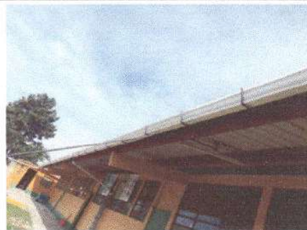
Foto 10: 7 canales y bajadas de aguas pluviales (sustitución de canal de pvc)
