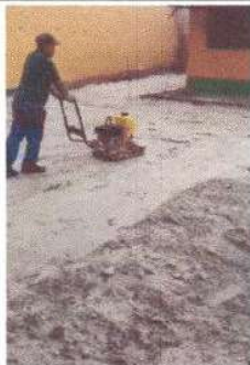
Foto 3: 6 PISO ( Reparación de piso de torta de concreto)
