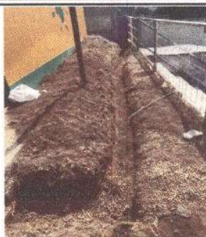
Foto 7: 14 RED DE DRENAJE (14.4 Sustitución de tubería pvc línea principal aguas pluviales)
