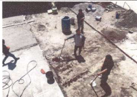
Foto 6: 6 PISO (Reparación de piso de torta de concreto)
