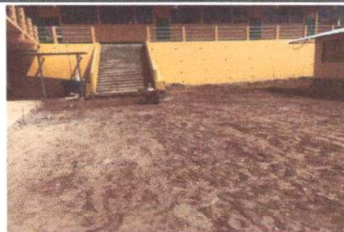
Foto 2: 6 PISO (6.1 Reparación de piso de torta de concreto )
