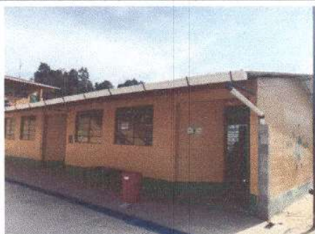
Foto 9: 7 canales y bajadas de aguas pluviales (sustitución de canal de pvc)
