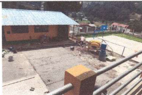
Foto 8: 1.8 Sustitución de cajas de registro
